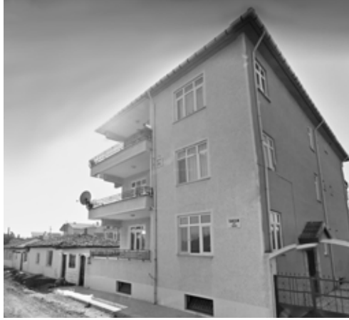
Asiye ninenin evinin üzerine yapılan apartman binası. Babaeski, Fevzi Çakmak Mahallesi, (Eski Maacır Mahallesi) 387. sokak.
