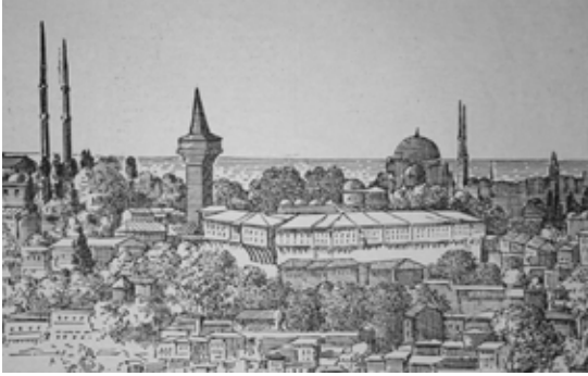
Eski yangın kulesi.
