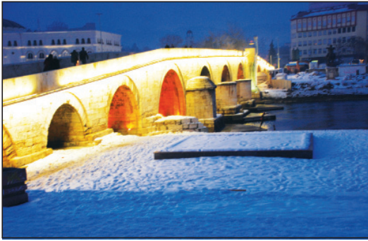
Köprünün son aydınlatma sistemi.
