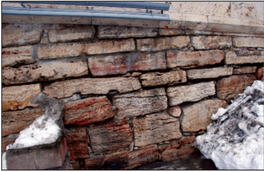
Roma köprüsünün kanıtı gâilesiyle kaba yonu taşlarının çimento ile birbirine tutturulması.
