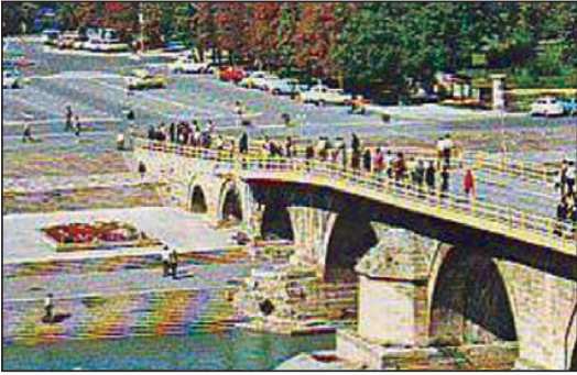
Demir korkuluklarda iki parçalı görünüm.
