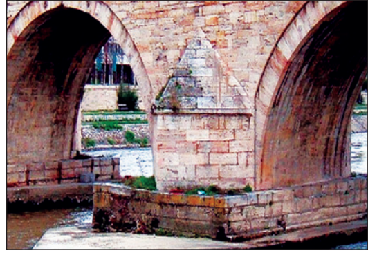
Ayağın oturduğu 'kürsü' (sömel) ve suyun üstünde üç sıra kürsü taşı.
