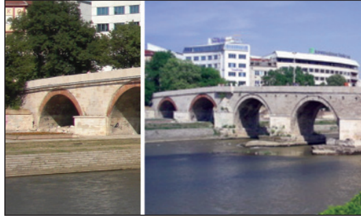
Kuzey, birinci ayak selyaranı ve ikinci ayak rıhtım duvarı bitişikliği.
