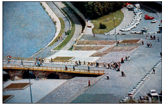
Depremden önce güneybatı yakasında eğim.
