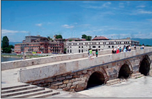
Güney kesimi, akar cephesinde beşinci, altıncı ve yedinci kemerler.
