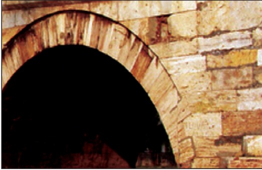
İnce yonu küfeki taşından yapılmış sarı renkli tempan (yan) duvar taşları.
