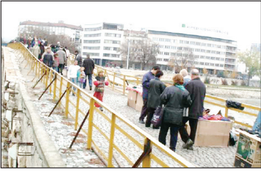
1992 yılında demir korkulukların sökülmesi.
