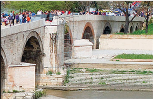
Kuzey kesimi, birinci payanda ve ikinci ayağın rıhtım duvarıyla bitişik hali.
