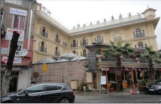
Hümaşah Sultan Hamamı'nın yeni görünümü.
