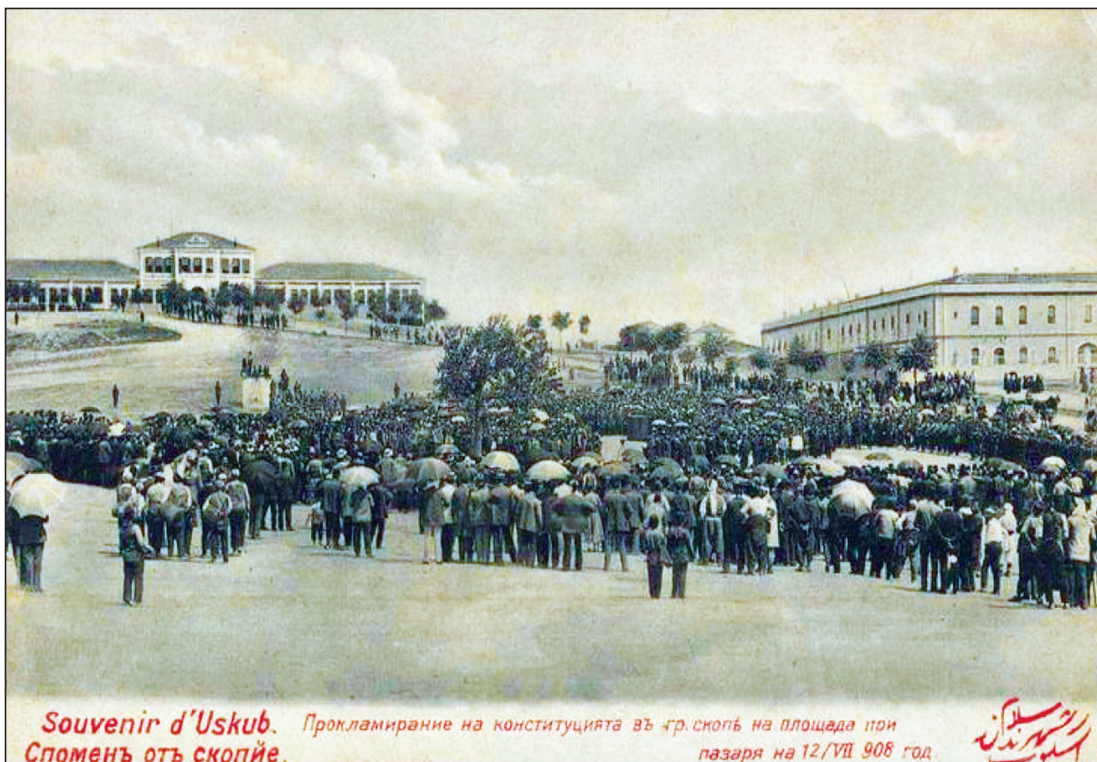
Kale Meydanı, Osmanlı Kasarna'sı ve Eski Hapishane Binası.
