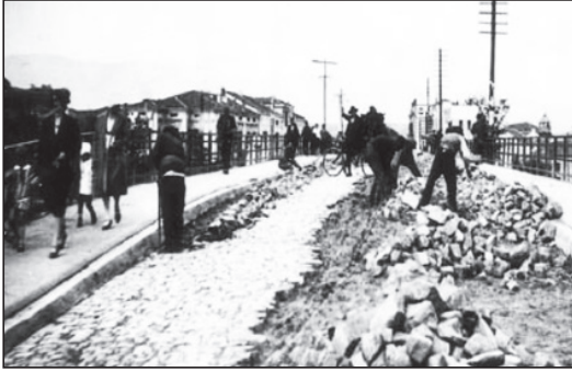
Köprüdeki moloz taşların sökülmesi.
