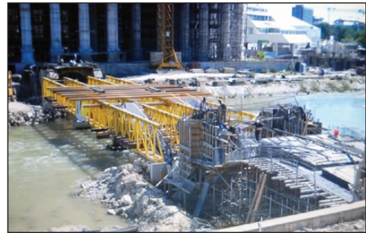
Yapım aşamasında Göz Köprüsü.
