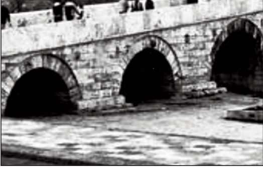
Beşinci ve altıncı ayakta yükseltilmiş sömel izlenimi.
