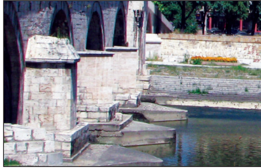
İki metre kalınlığında beton mahmuzlar.
