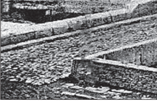
Taş korkulukların altında yola bakan kısmı köşebend demirli dar bordür düzenlemesi.
