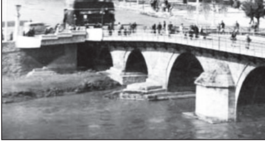
Altıncı, yedinci ayaklar ile rıhtım ayağının toprak altında gömülü olması.
