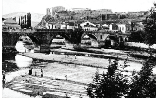
Taş Köprü ve su dolabı.
