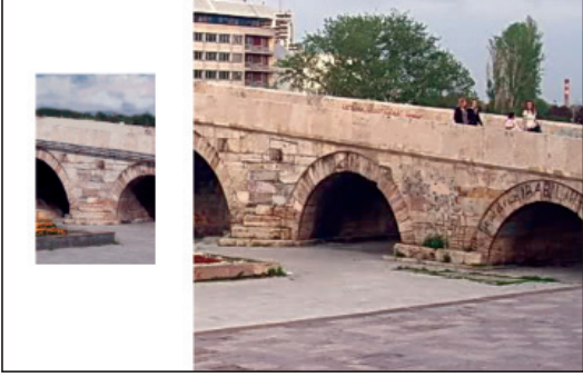
Beşinci selyaran ve altıncı ayakta yastık taşı çıkıntısı.
