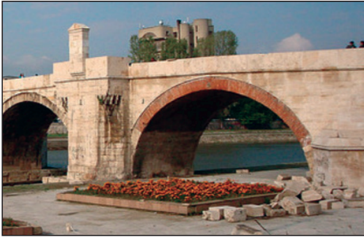
Silinmiş veya yeniden döşenmiş kuzey tempan duvarlarının taşları.
