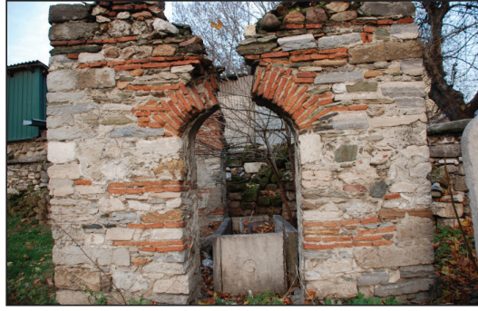
Yahyâ Paşa Câmii haziresinde bulunan baldaken tarzında inşâ edilmiş Yahyâ Paşa'nın oğlu Mehmet Paşa Türbesi.
