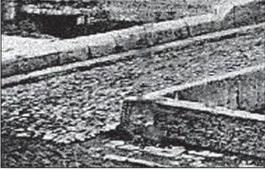
Moloz taşla döşenmiş köprü tabliyesi ve orta bölümde hattı ictimâ.
