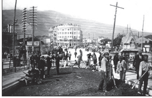
1920'li yıllarda köprü tabliyesinin onarımı.
